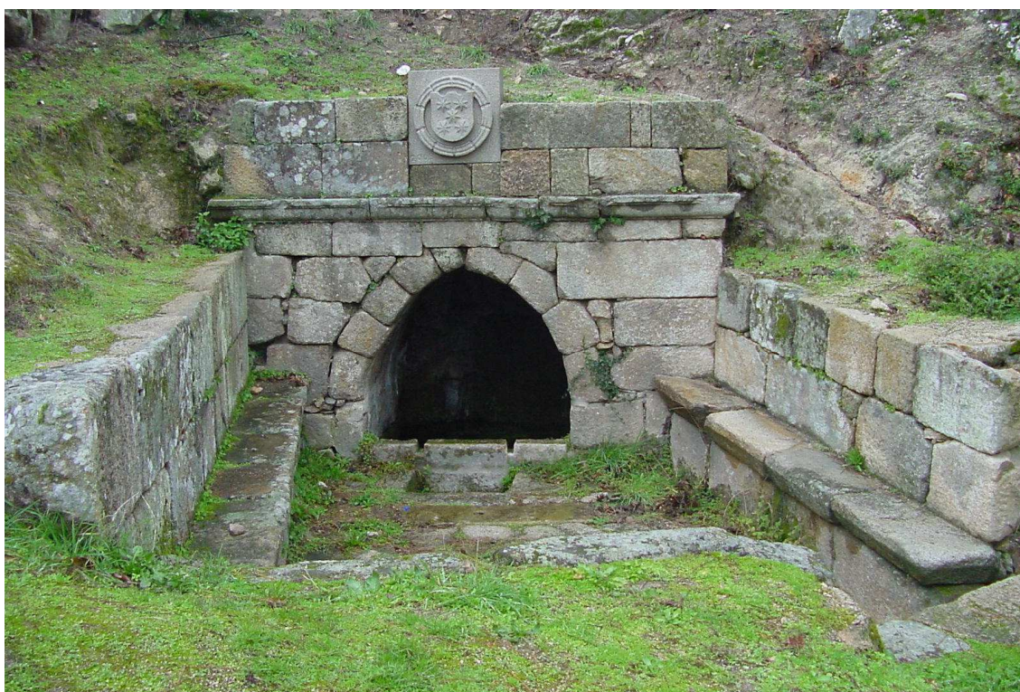
Fuente de Monterrei, tras su reparación, con la copia de la labra heráldica que le fue colocada.
