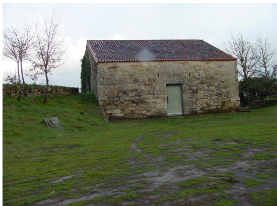
Edificio "O POLVORIN" tras su rehabilitación, con la falsa labra, colocada a su izquierda.
